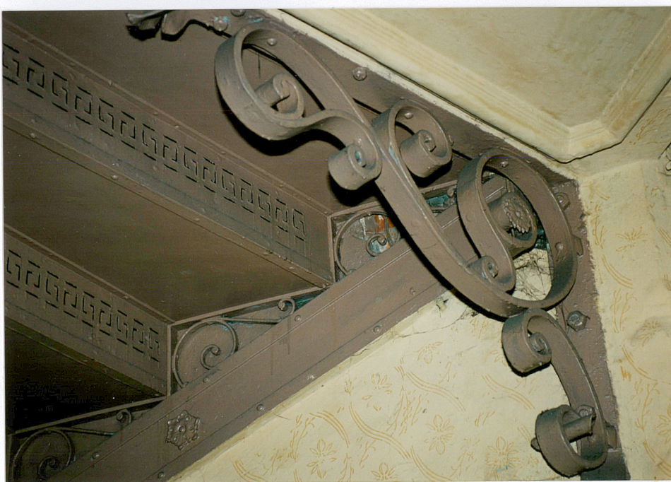
27. STALOWY WSPORNIK POD SPOCZNIKIEM KLATKI SCHODOWEJ
