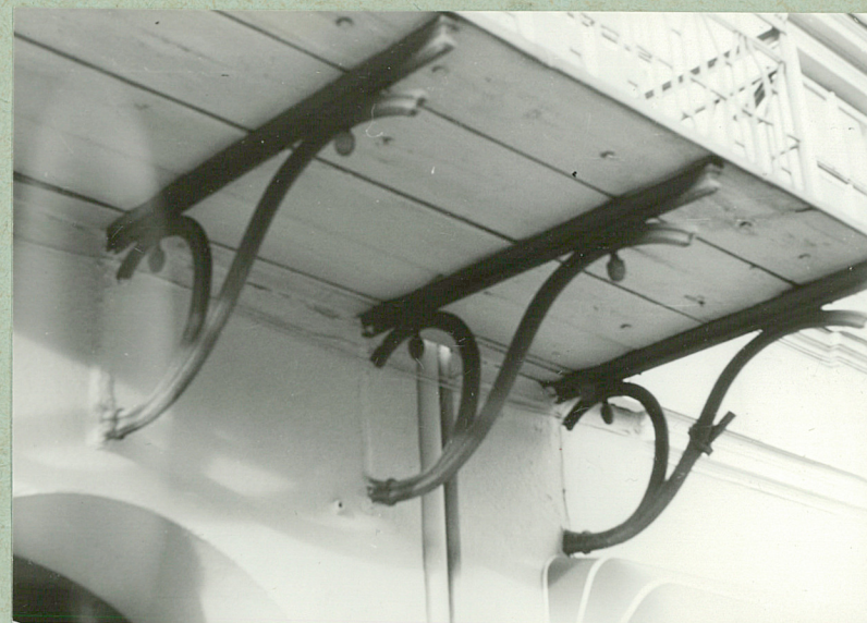
Wsporniki podtrzymujące balkon w elewacji frontowej
