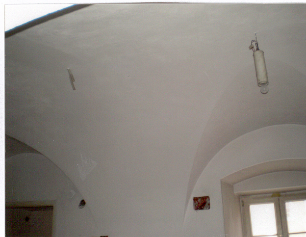
19 Wnętrze parteru – fragment sklepienia kolebkowego z lunetami
