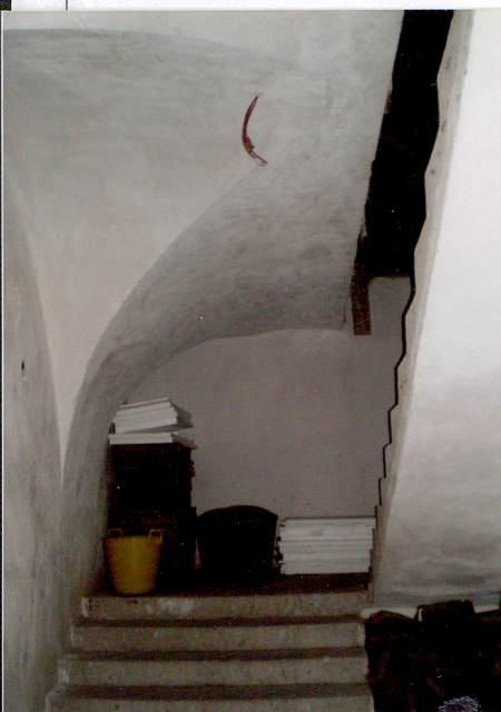
20 Wtórna klatka schodowa – widoczne sklepienie krzyżowe
