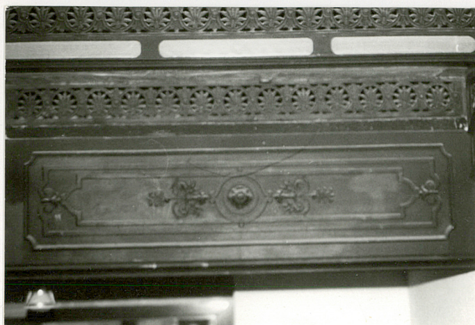
Detal żeliwnej konstrukcji klatki schodowej.
