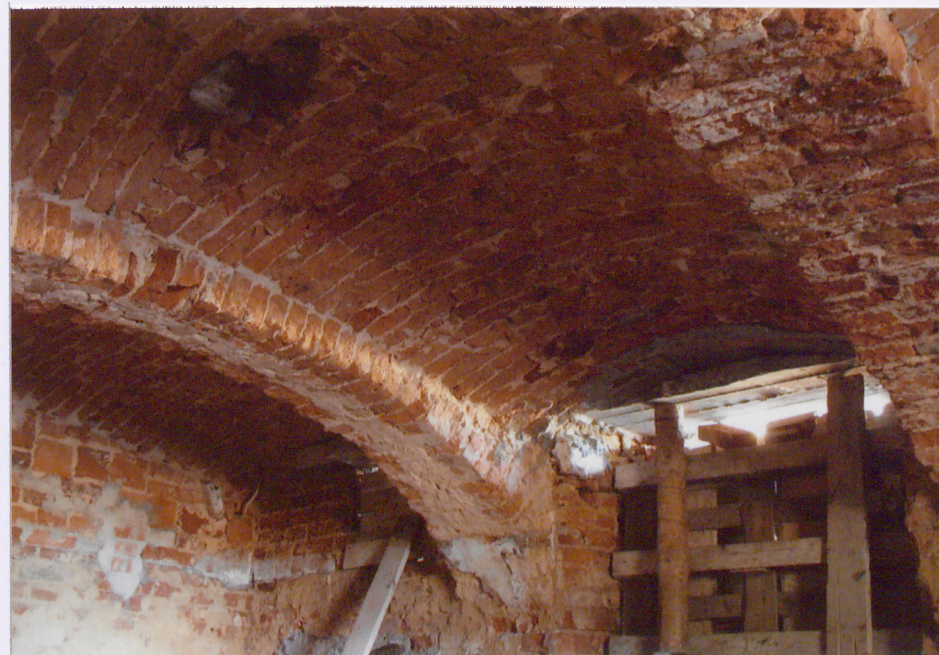
fot. 12. Piwnice - sklepienie kolebkowe na pasowych gurtach
