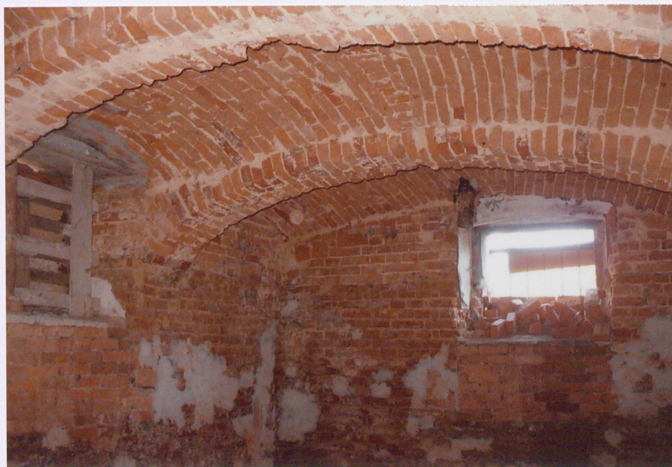
fot. 11. Piwnice - sklepienie kolebkowe na pasowych gurtach
