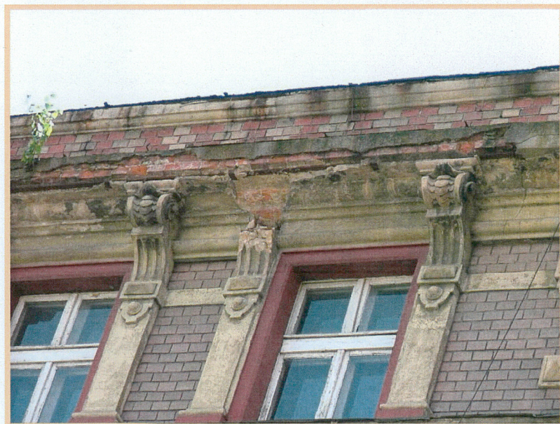
Uszkodzenia gzymsu pod attyką
