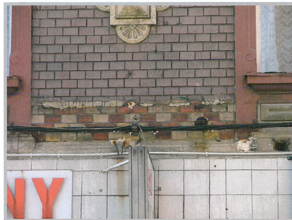
Fragment ornamentu z dwukolorowej cegły licowej na elewacji frontowej
