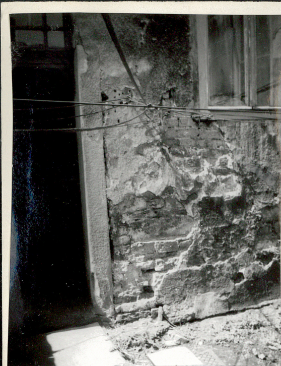
Elewacja podwórzowa-kamienne węgry wejścia i mur przyziemia
