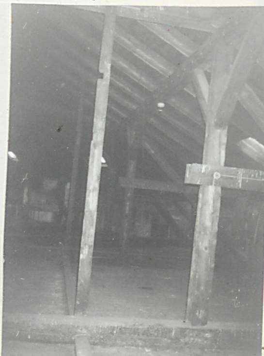
Elementy więźby dachowej.
