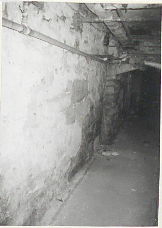
Piwnica - schody, mur fundamentowy( kamień,cegła),strop.
