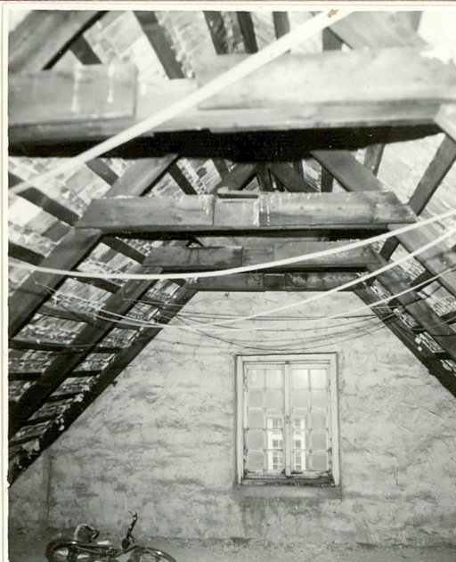
16. Konstrukcja więźby dachowej
