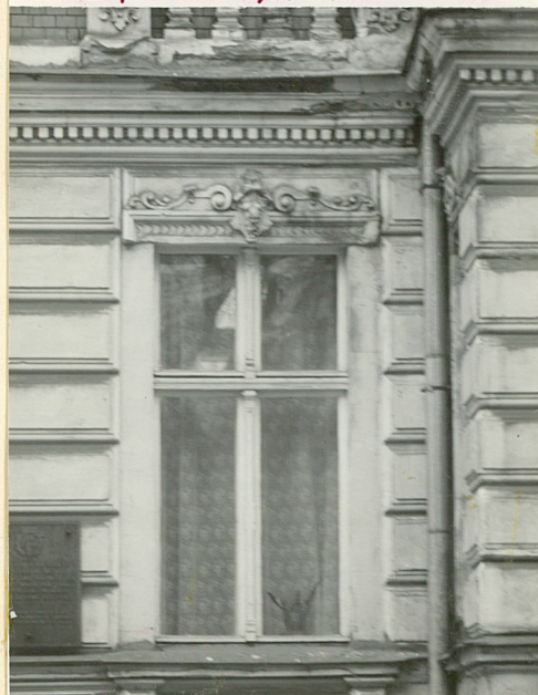
15. OTWÓR OKIENNY Z OKŁADKĄ I OBRAMOWIENIEM, GŁYMS MIĘDZYKONDYGNACYJNY
