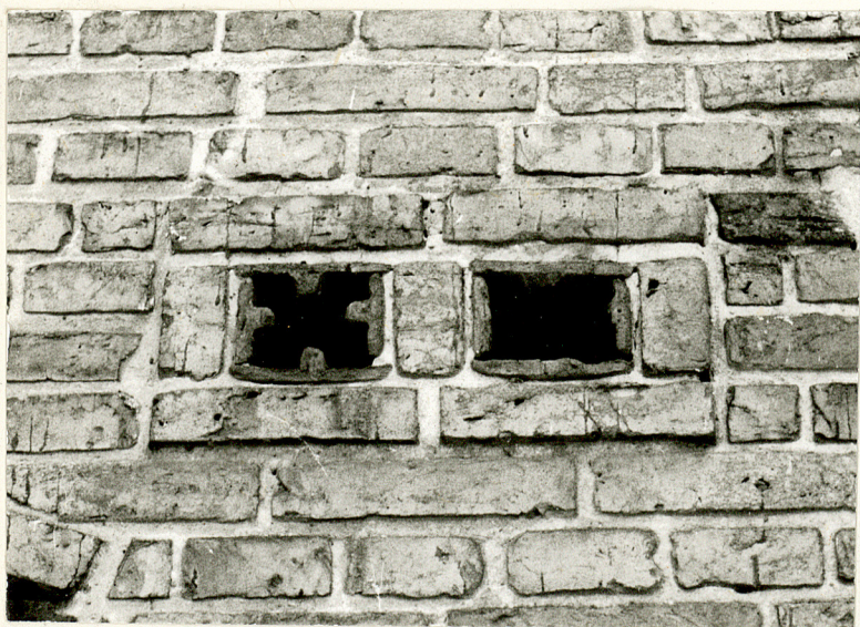
Fot.18.Elewacja frontowa wyloty wentylacyjne.
