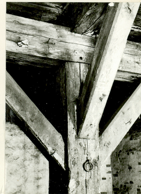
Fot.14. Drewniana konstrukcja podtrzymująca 3-cią kondygnację.
