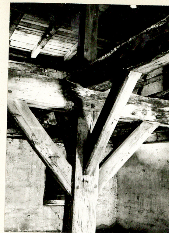
Fot.17.Drewniana konstrukcja podtrzymująca 4-tą kondygnację.
