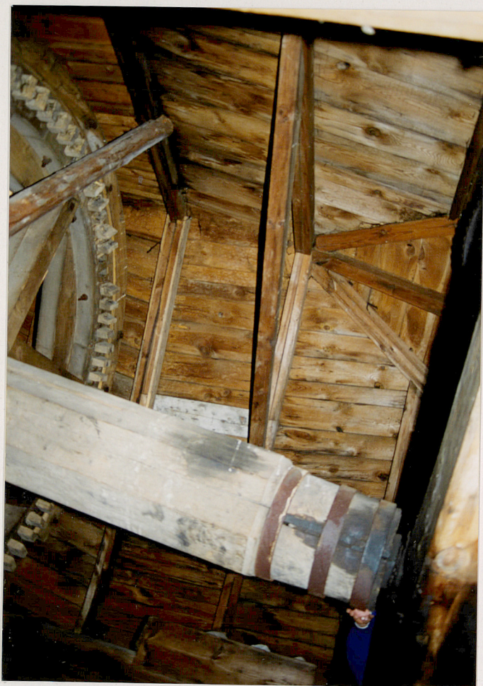
11. Wał poziomy- wyprowadzenie na zewnątrz
