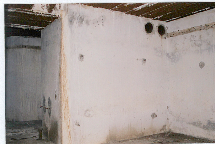
Fot. 16. Północno-zachodnia część dużej izby załogi (nr 3), z prawej u góry Otwory po rurach wentylacyjnych, z lewej przejście do izb nr 2, 5 i 1.
