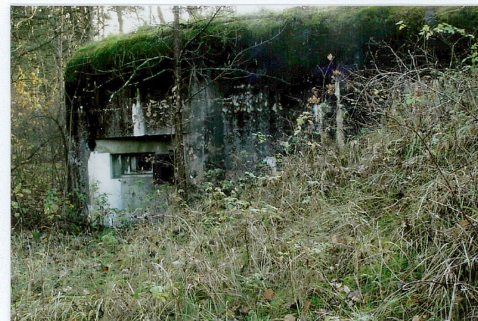
Fot. 7. Ściana boczna północno-wschodnia, od lewej: strzelnica ckm, wyjście zapasowe z pancerną okiennicą.
