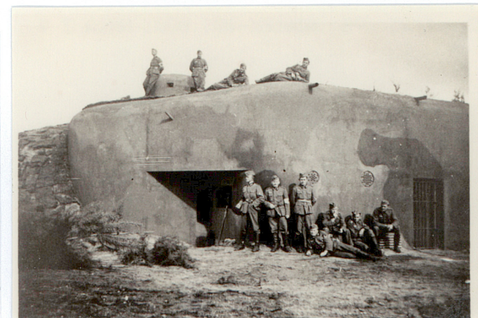
Fot. 2. Niemiecka fot. z 1939 r., widok z płudnia, od lewej: blok kopuły pancernej ckm, strzelnica ckm, wyżej w okapie rura wyrzutni ładunków oświetlających, zrzutnia powietrza ckm zachodniej izby bojowej, czerpnia powietrza, wejście do schronu zamykane dwuskrzydłową kratą przeciwszstormową, przy stropie ściany tylnej rzygacze do odprowadzania wody opadowej ze stropu. Widoczny kamuflaż na ścianach schronu. Przed schronem i na stropie przy kopule pancernej ckm żołnierze niemieckich oddziałów służby tyłów.
