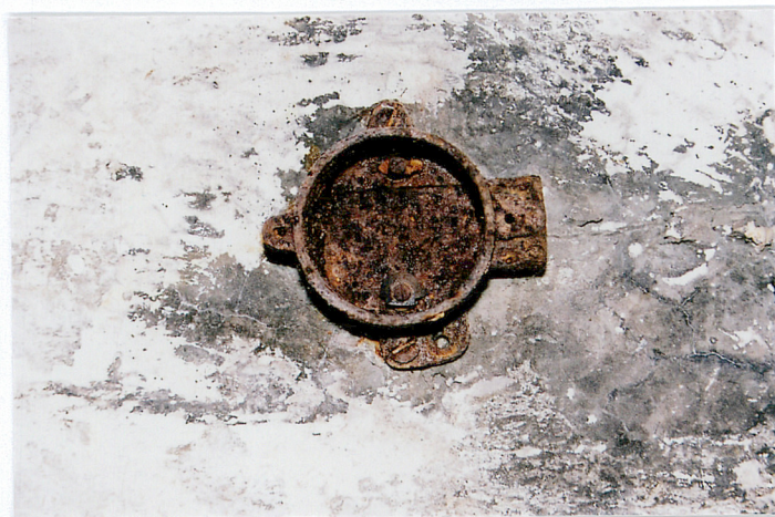
Fot. 21. Obudowa natynkowego włącznika/wyłącznika elektrycznego w korytarzu nr 9.
