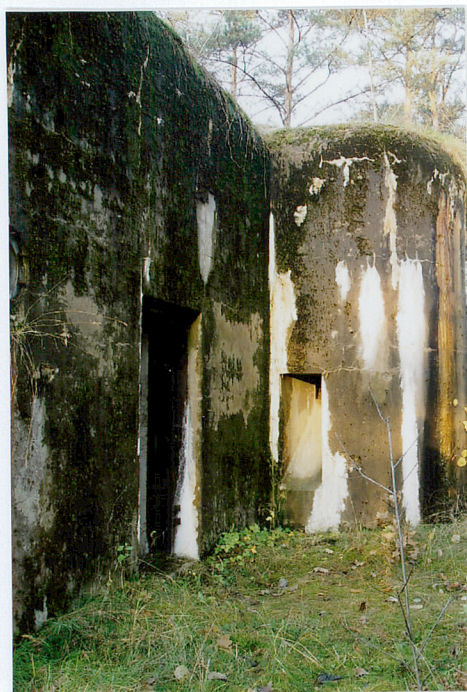
Fot. 5. Ściana tylna południowo-wschodnia z wejściem, z prawej strzelnica rkm obrony wejścia.
