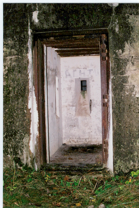
Fot. 6. Wejście do schronu w ścianie tylnej z zachowanymi odrzwiami dwuskrzydłowej kraty przeciwsztormowej, na wprost strzelnica rkm obrony wejścia.
