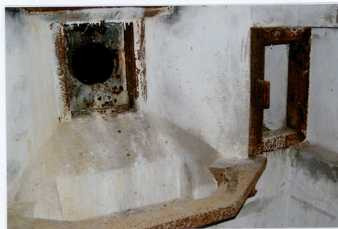
Fot. 22. Strzelnica ckm we wschodniej izbie bojowej, z prawej wyrzutnia ładunków oświetlających.
