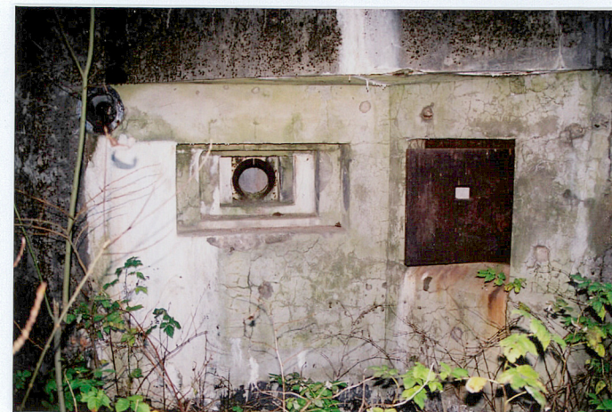
Fot. 8. Ściana boczna północno-wschodnia ze strzelnicą ckm, z lewej zrzutnia powietrza, wyjście zapasowe z pancerną okiennicą ze strzelnicą rkm.
