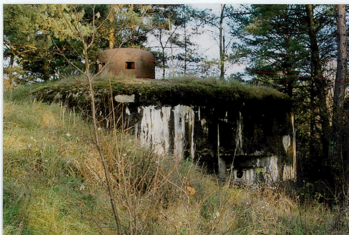
Fot. 1. Widok schronu z południowo-zachodu na blok kopuły pancernej ckm z lewej i ścianę boczną ze strzelnicą ckm.
