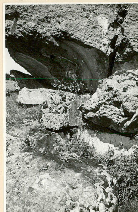
fot.3. Widok z wnętrza schronu na pół- nocno-wschodnią część schronu. Widoczny fragment łuku stropowego i ściany działowej między kazama- tą 2 i 3.
