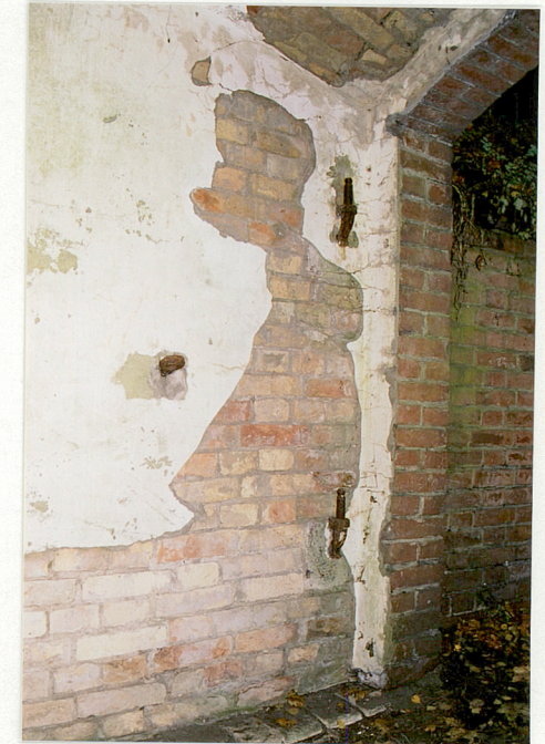
Fot. 9. Zawiasy dwuskrzydłowych drzwi w południowym wyjściu wybieżni, bliżej kółko do ryglowania drzwi.
