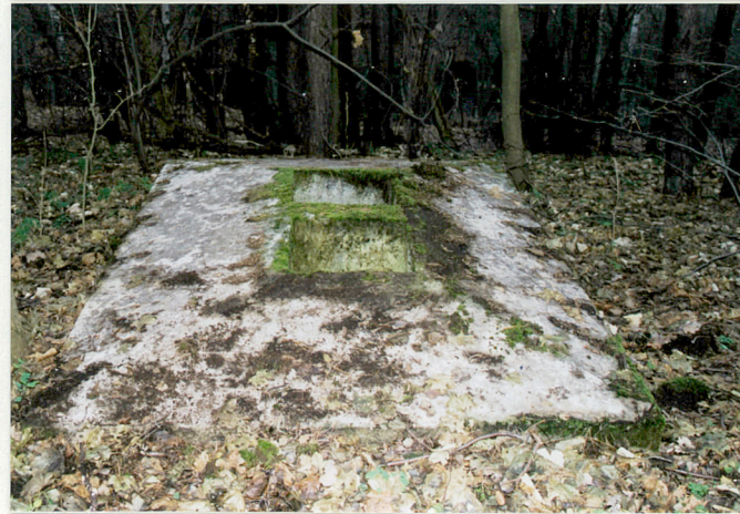
Fot. 6. Komin wylotów kanałów wentylacyjnych prochowni w koronie wału wysokiego.
