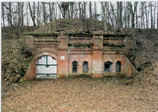
Fot. 1. Widok od wschodu na ścianę czołową prochowni (nr 49 na karcie ewidencyjnej fortu I Centralnego). Z lewej brama poterna prowadzącej do drogi dozorowania, Z prawej okna kazamat.
