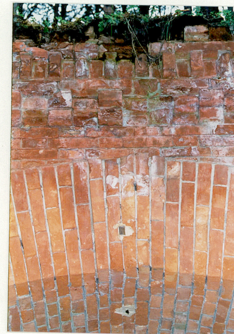
Fot. 8. Słabo czytelny numer taktyczny na łuku bramy, wyżej uszkodzona korona muru.
