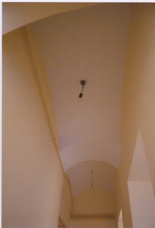
Sklepienie korytarzyka na parterze
