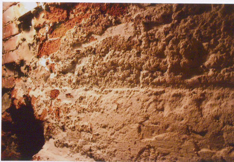
Spęcherzenia tynku w piwnicy
