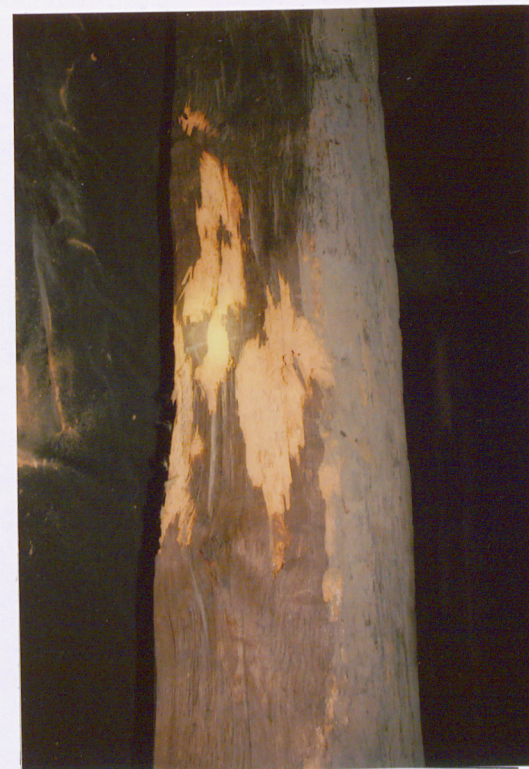
Uszkodzenia więźby dachowej
