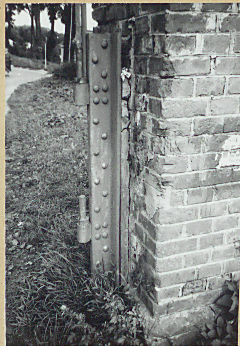
Konstrukcja do zawiesz- nia skrzydła bramy przy filarze wschodnim
