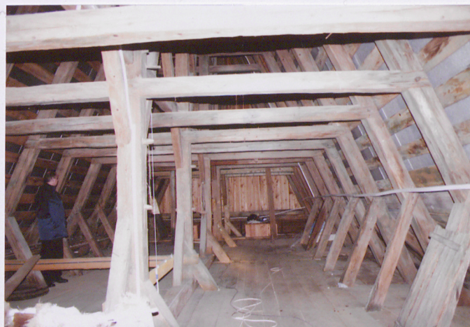
Widok ogólny więźby dachowej; widoczna rama storczykowa, dolne jętki, miecze stopowe poprzeczne storczyka i miecze stopowe wiazara
