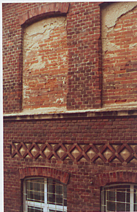
ZAMUROWANE OKNA W ELEWACJI ZACH.
