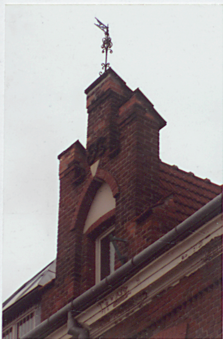
SZCZYT Z WIATROKAPEM NA ELEWACJI FRONTOWEJ
