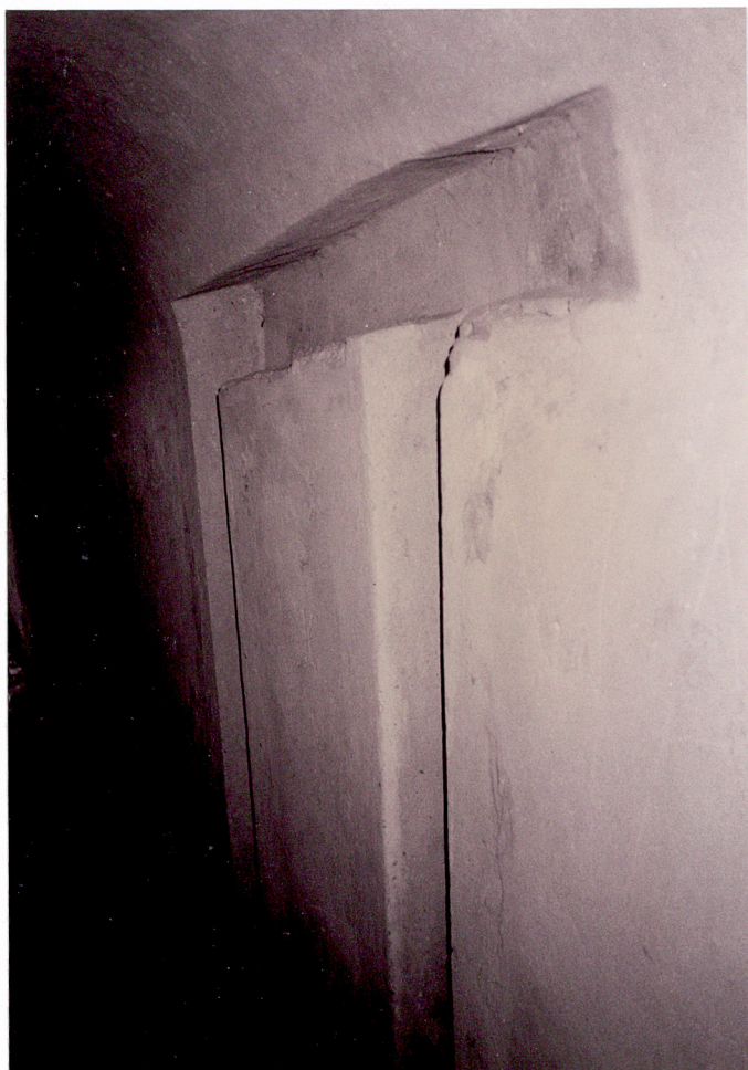
Prowadnice belek do barykadowania poterny schronu pogołowia
