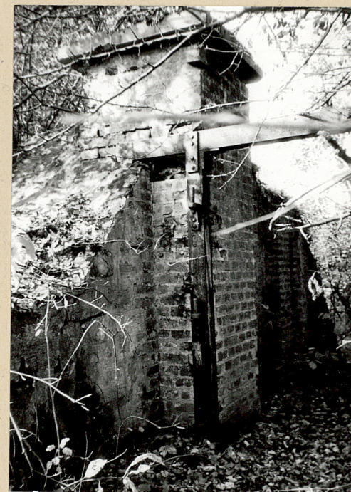
Filar zachodni bramy z e stalową futryną
