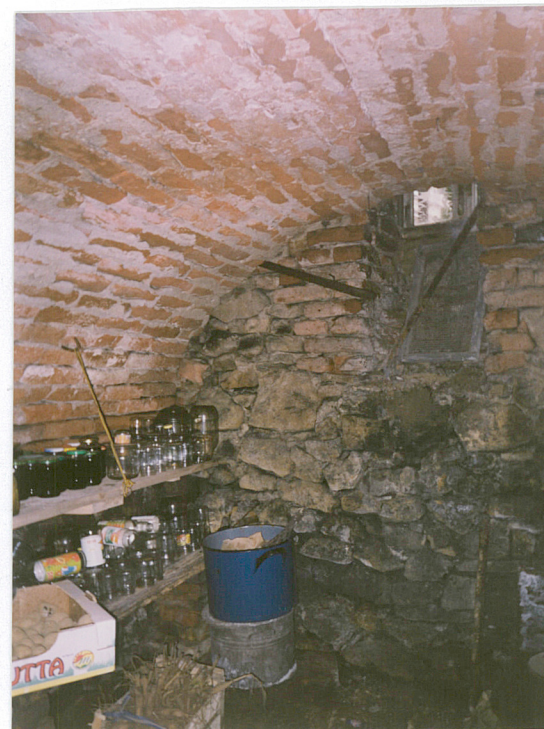
sklepienie w piwnicy w części północno-zachodniej budynku.
