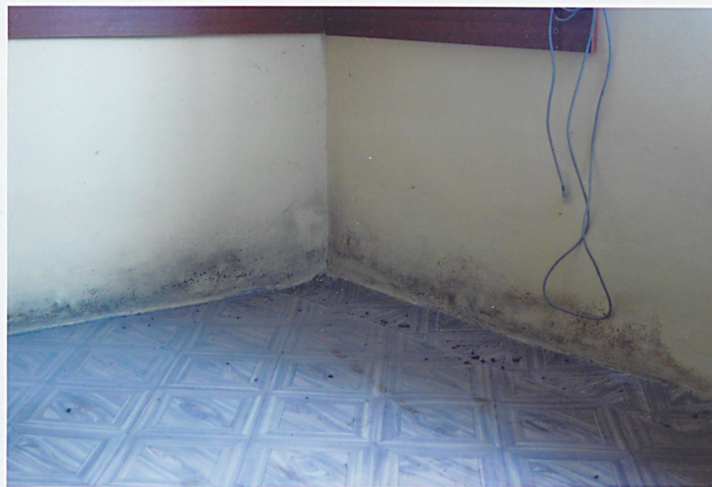
Jadalnia, widok zagrzybionej ściany
