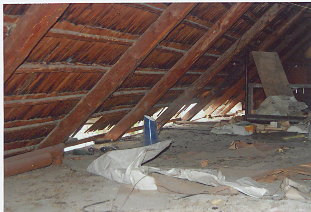
Wieżba dachowa w połaci zachodniej
