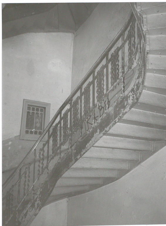
Pion klatki schodowej z metalową konstrukcją schodów
