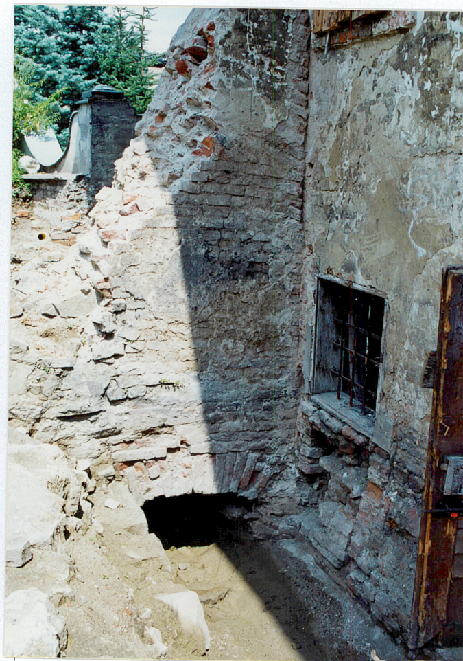
Przypora w narożniku NW z przepustem na wody opadowe
