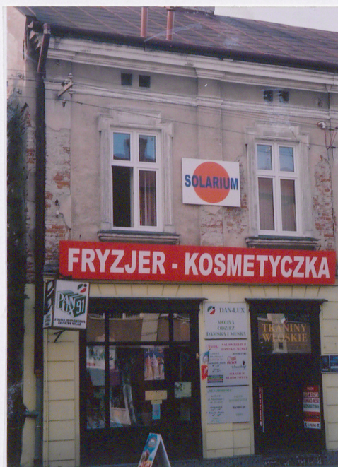
Zniszczone tynki w elewacji frontowej i szczytowej
