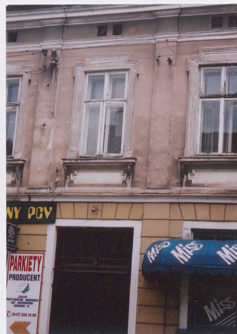
Zniszczone tynki w elewacji frontowej i szczytowej
