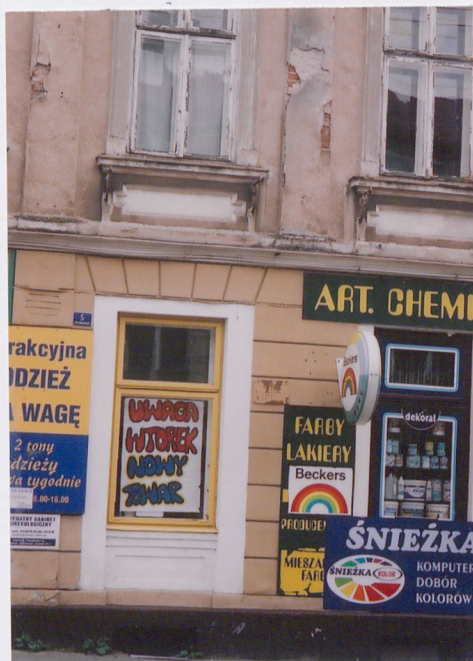
Zniszczone tynki w elewacji frontowej i szczytowej
