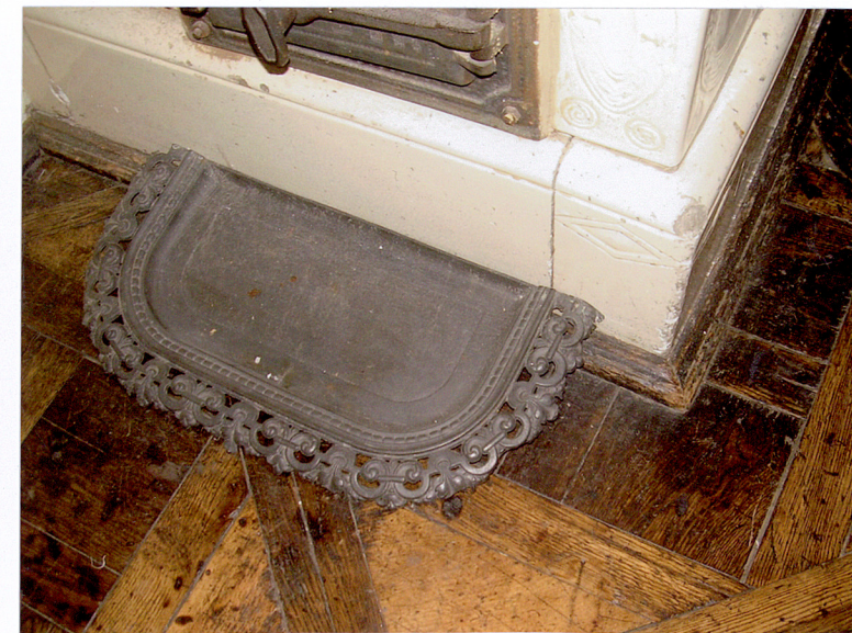
30. Żelazna płytka zabezpieczająca podłogę przy piecu.
