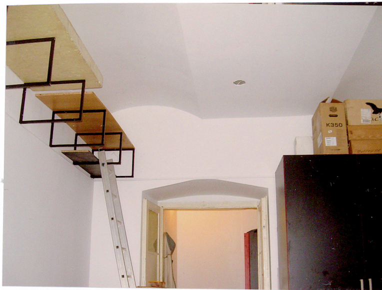
13. Sklepienie odcinkowe w pomieszczeniu na parterze.
