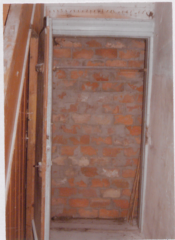
ZAMUROWANY OTWÓR DRZWIOWY Z KORYTARZA - CZĘŚĆ STARSZA
