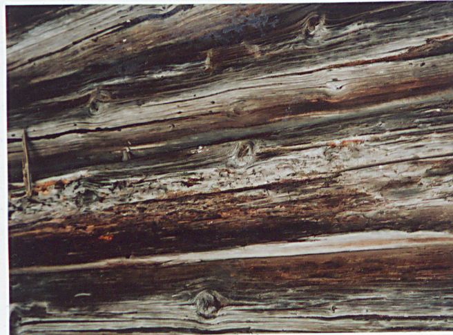
ślady zniszczeń belek przez olewnojady.
