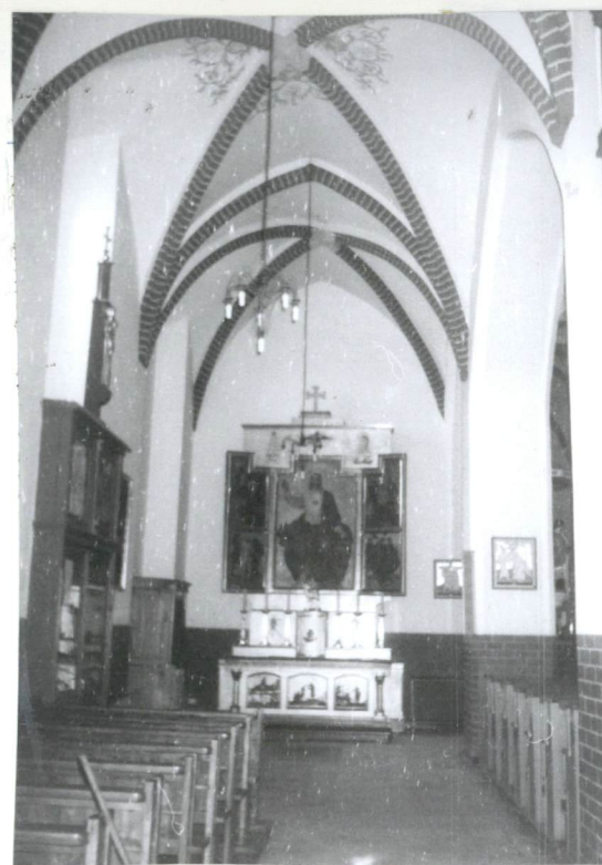
Nawa półn.- sklepienia krzyżowo-żebrowe ze zwornikiem.
