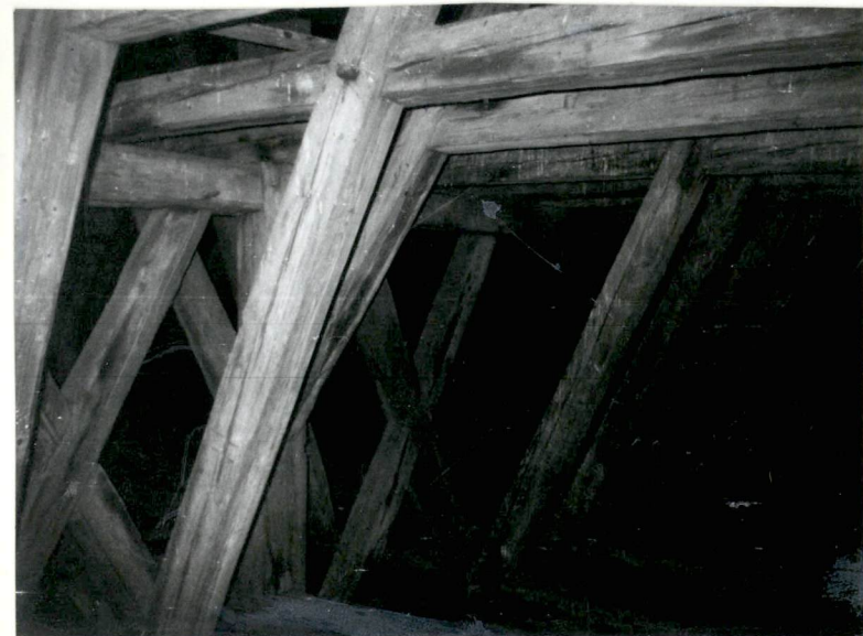
Elementy konstrukcyjne(drewniane) więźby dachowej.Konstrukcja storczykowa.
