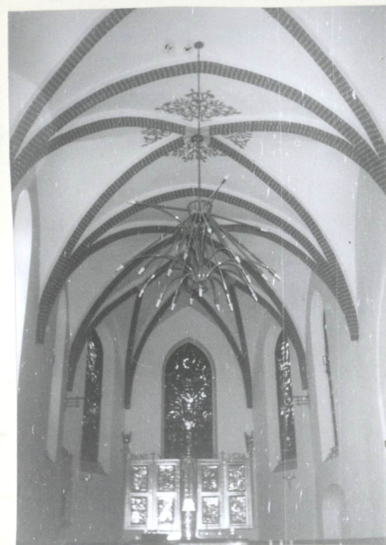
Prezbiterium-sklepiona krzyżowo-żebrowe ze zwornikiem.
