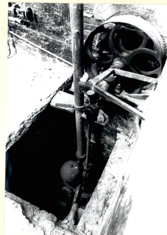
Fot. 23. Pionowa maszyna parowa w kotłowni.
