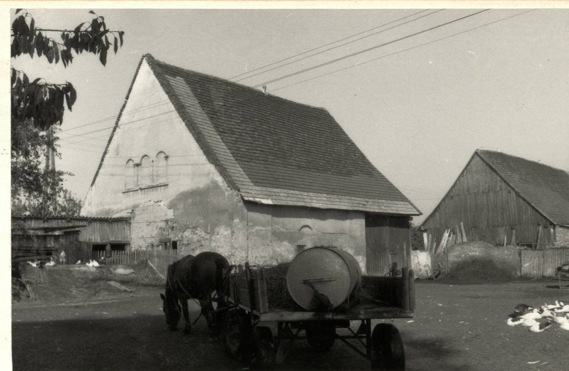
Fot.30. Stodoła /18/ - południowa ściana szczytowa z charakterystycznymi blendami i wschodnia elewacja dłuższa.
