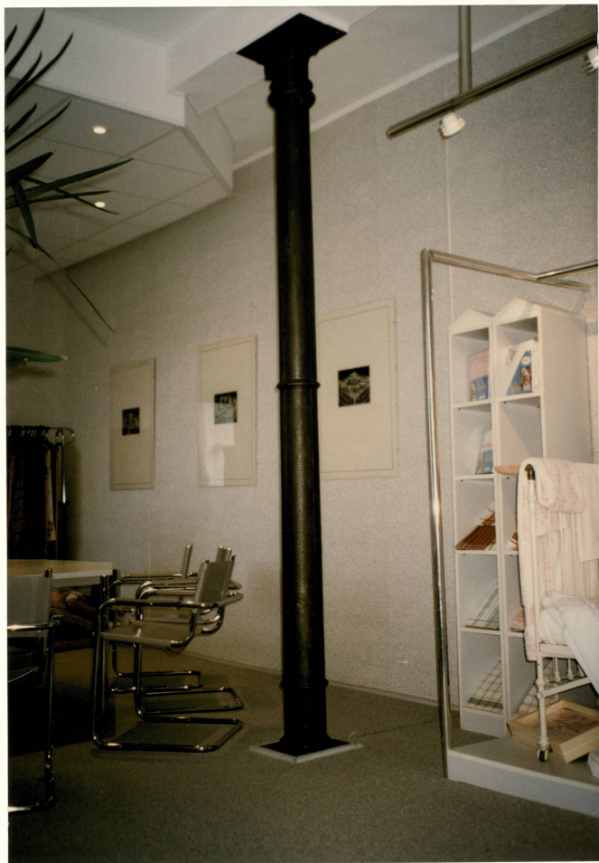
4. Wyeksponowany słup żeliwny, wewnętrznej konstrukcji nośnej w jednym z pomieszczeń biurowych, neg. 600/555/1.
