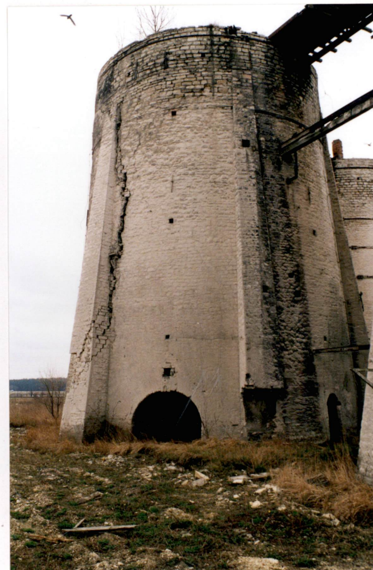
PIEC ŚRODKOWY - WIDOCZNE PEKNIĘCIA PROTYPORY
