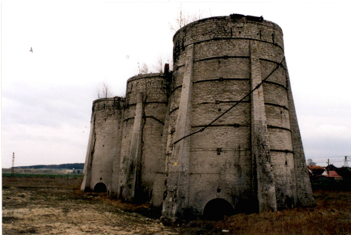
BATERIA 4 PIECÓW TYPU „BUNKE-FACHT” (WIDOCZNE PEKNIĘCIA PIECÓW BEZ KOTŁOW IŚCIĄGÓW)
