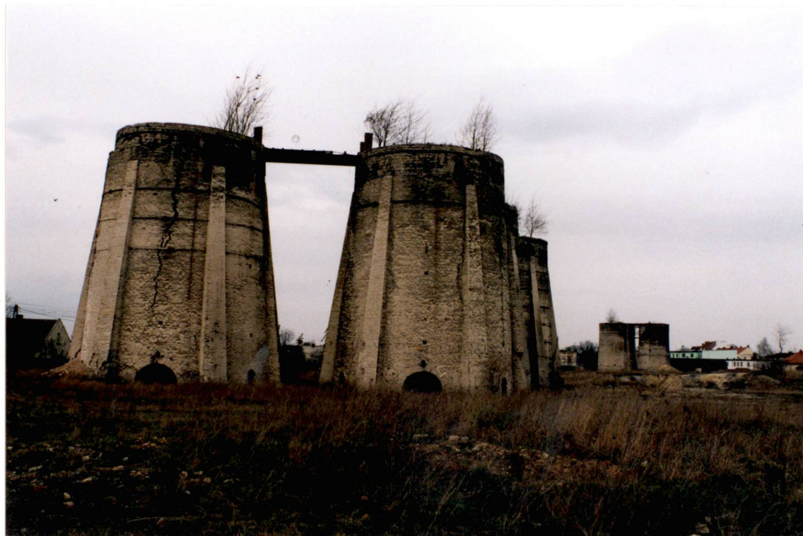
BATERIA 4 PIECÓW SZYBOWYCH typu „BUNKE-PACHTA” (W GIEŚBI WIDOCZNA BATERIA PIECÓW „PAŁBROWSKI”)
