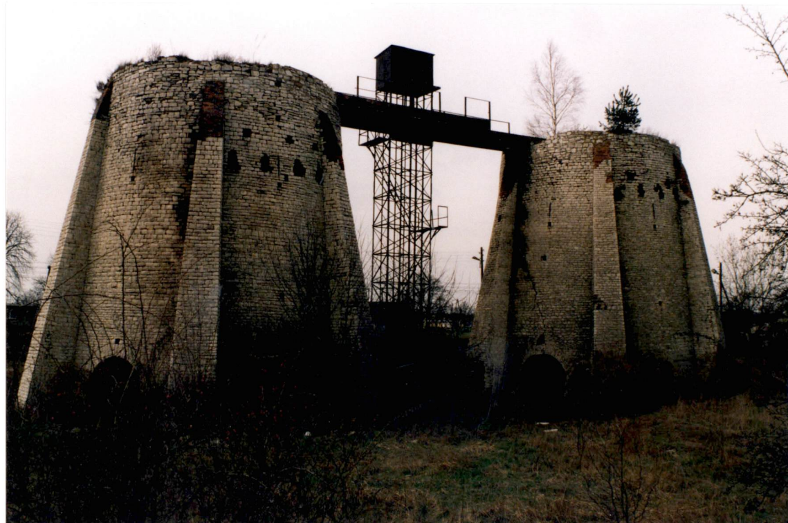
BATERIA 2 PIECÓW Z POMOSTEM ROBOCZYM I WYCIĄGIEM DO TRANSPORTU MATERIAŁÓW DO WSADU PIECOWEGO
