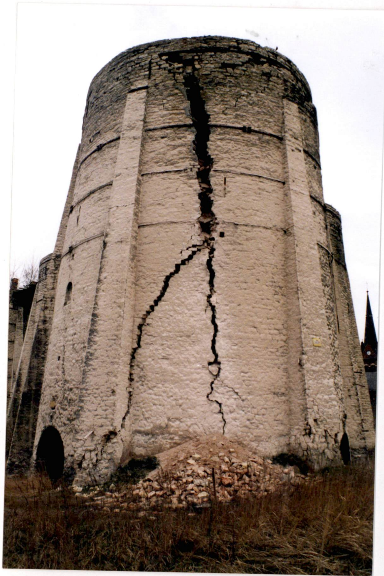
PEKNIETY PIEC BATERII „BUNKE-PACHT” GOGOLIN — LICZNE PĘKNIECIA PIECA I ODSPOJENIE FOTO: A. ZBIEGNIENI — IV 2000 R. PROTYPORT — SKRAJNY PIEC BATERII
