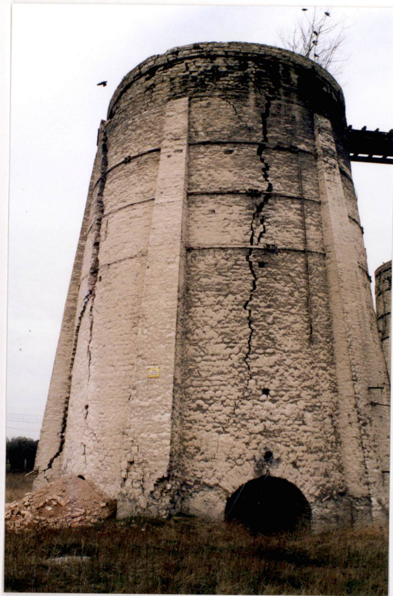
PEKNIETY PIEC BATERII „BUNKE-PACHT” GOGOLIN — LICZNE PĘKNIECIA PIECA I ODSPOJENIE FOTO: A. ZBIEGNIENI — IV 2000 R. PROTYPORT — SKRAJNY PIEC BATERII
