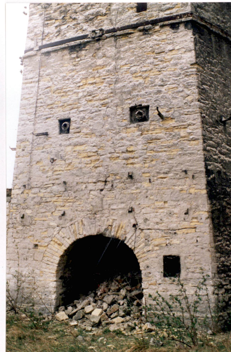
PIEC SZĘŚCIOKĄTNY Z OTWOREM WYDOBYWCIĄ
