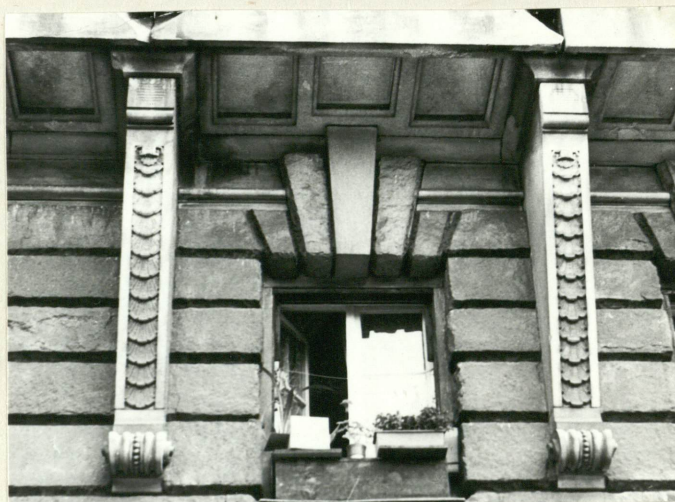
Fot.11. Elewacja zachodnia - okno I p. i wsporniki balkonu.
