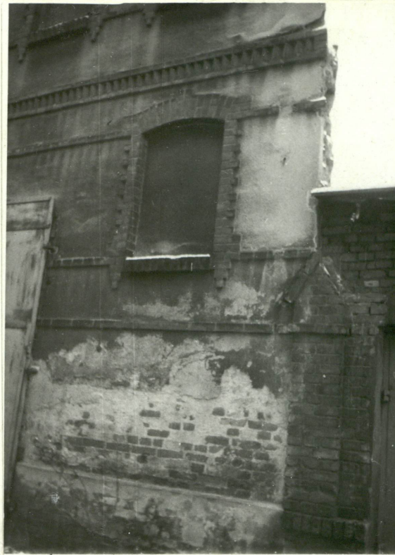
Przyziemie (elew.wsch)-słup b.ogrodzenia naroże północne -zniszczone tynki
