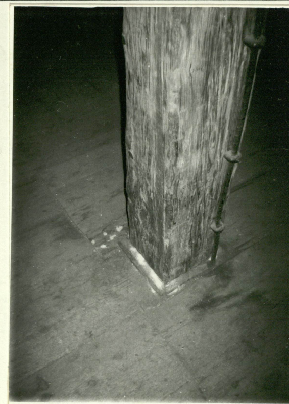
Słup konstrukcyjny (porażony przez owady)
