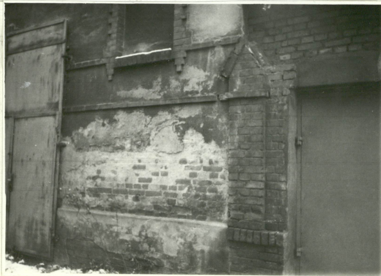
Przyziemie (elew.wsch)-słup b.ogrodzenia naroże północne -zniszczone tynki
