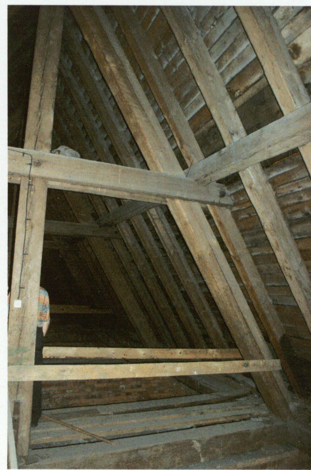
Konstrukcja więźby dachowej.
