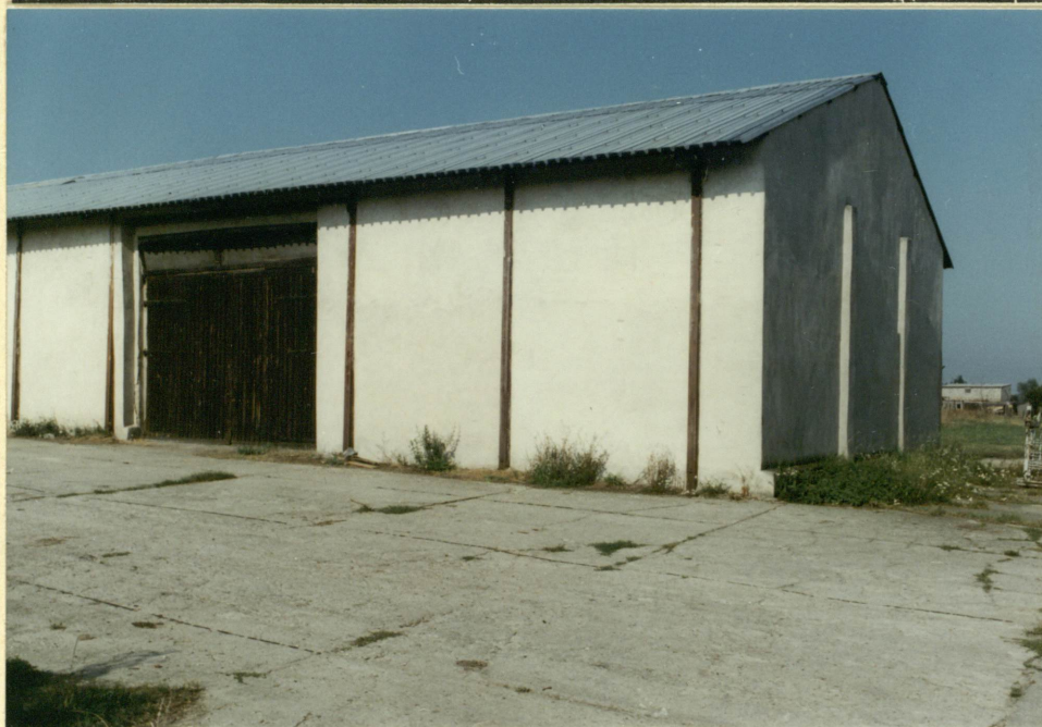
Fot.19. Północna część stodoły /5/ - widok od strony wschodniej - ciemne pionowe pasy widoczne na elewacji dłuższej to stalowe wzmocnienia ścian.
