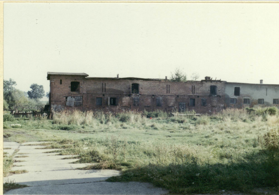
Fot.22. OBORA-STAJNIA /4/ - zachodni fragment elewacji południowej doprowadzony do całkowitej ruiny dach zawalony do wnętrza budynku (własność prywatna).
