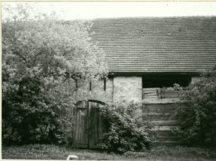
Fot.4. Fragment elewacji północnej przęsło na osi poprzecznej jest znacznie węższe i z skle- pionym nadprożem.
