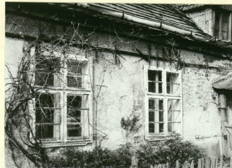
Fot.6. Fragment elewacji południowej z oryginalnymi otworami okiennymi wypełnionymi drewnianymi, oknami krosnowymi, podwójnymi, czteroskrzydłowymi z szkleniem ujętym w pojedyncze szczebli-ny poziome.
