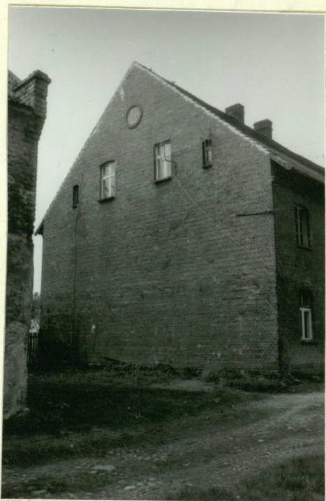
Fot.7. Dom mieszkalny /11/ południowa ściana szczytowa, o dwóch dolnych kondygnacjach ślepych, a w strefie szczytu - o czterech otworach okiennych; na osi szczytu, w ko- listej płytkiej blen- dzie monogram właści- ciela i data: "A.v.W. | 1896".
