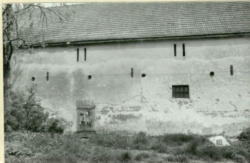
Fot.6. Fragment elewacji zachodniej → drzwi, okno, otwory wentylacyjne: do wnętrza i poddasza
