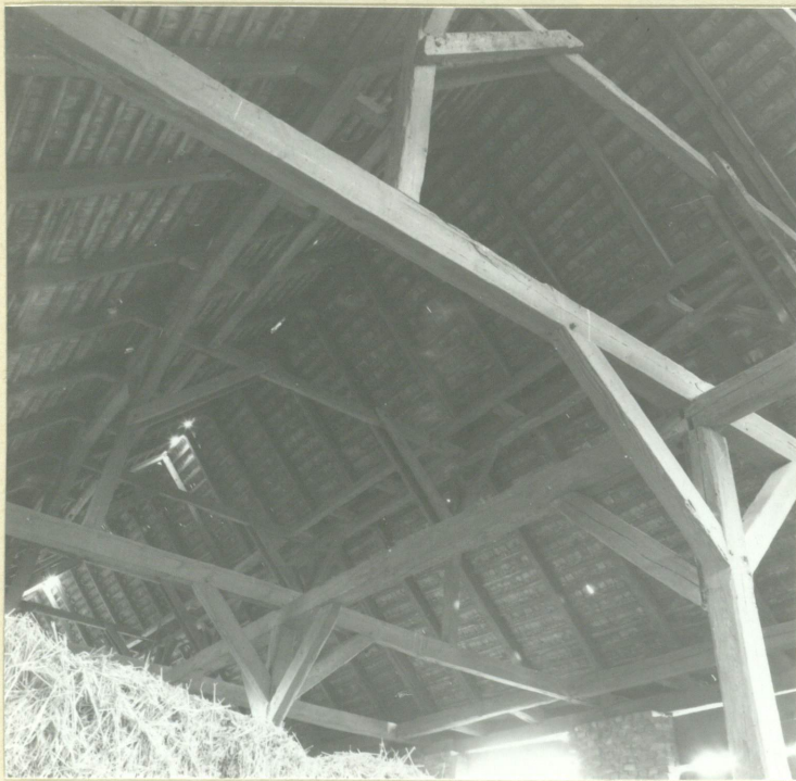
Fot.3. Wnętrze stodoły - fragment konstrukcji więźby dachowej.
