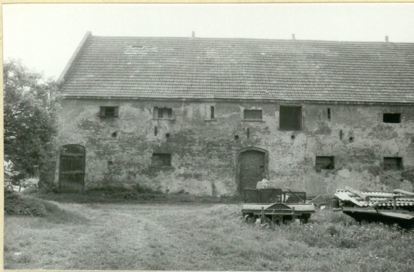
Fot.2. Południowy fragment elewacji wschodniej, z zamurowanym otworem drzwiowym.
