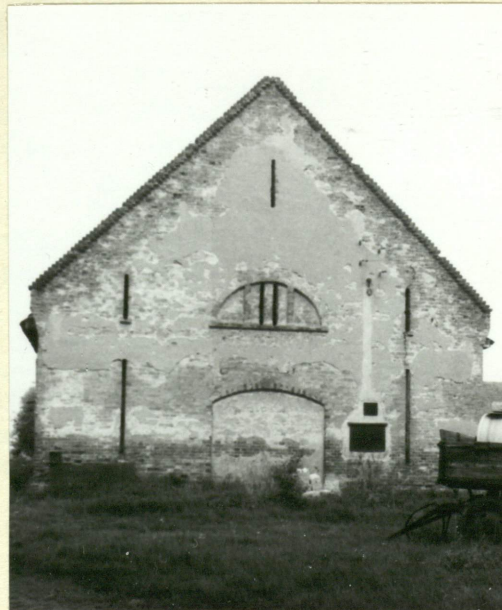
Fot.6. Wschodnia ściana szczytowa - co druga cegła w nadprożu to zendrówka.
