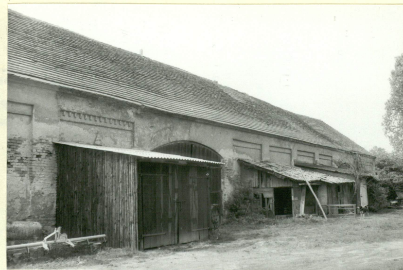
Fot.5. Wnętrze podwórza zachodniego - stodoła /12/ dłuższa elewacja wschodnia z artykulacją lizenowo-ramową.
