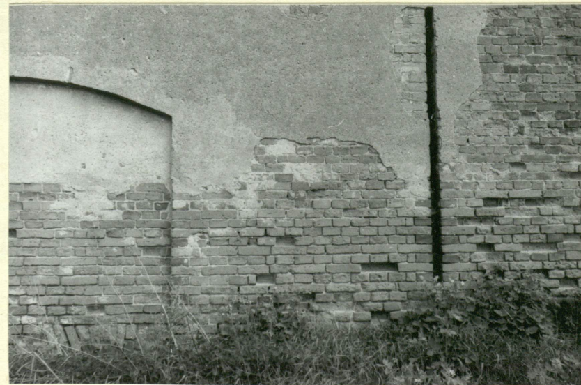
Fragment zachodniej ściany szczyto- Fot.7.wej → watek blokowy.
