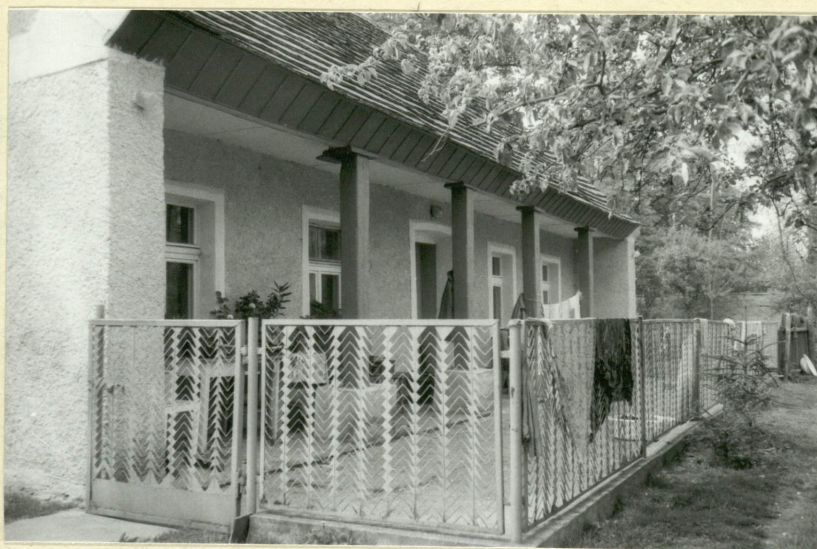
Fot.23. Dom ogrodnika /4/ → wschodnia elewacja dłuższa z charakterystycznym podcieniem na całej długości budynku. Pierwotnie słupy podpierające okap były o przekroju kolistym (czy kolumny, z kapitelami - ?) w czasie remontu w 1963 roku - słupy wymieniono na nowe o przekroju kwadratowym.
