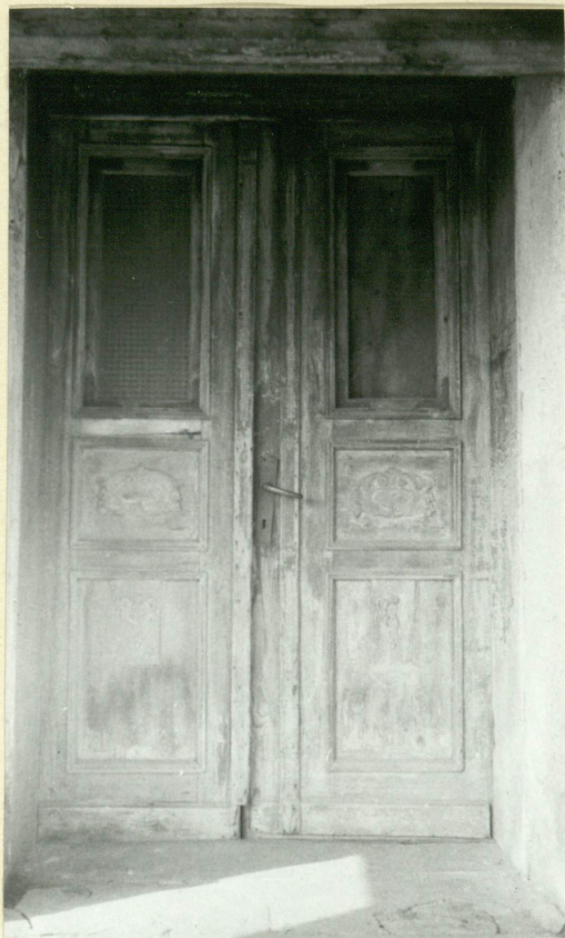
Fot.4. Główne drzwi wejściowe do budynku od strony podwórza folwarcz. Pozornie symetryczne, drewniane, ramowo-płycinowe, płyciny grube, nałożone od strony wnętrza sieni, od zewnątrz o krawędziach obwiedzionych listwami profilowanymi. Zamiast górnych płycin pełnych - są przeszklone skrzydła rozwierane jak okienne, ale brakuje w nich szyb. Dwie dolne płyciny z nałożonymi ornamentami drewnianymi. Skrzydła drzwiowe osadzone na zawiasach francuskich.
