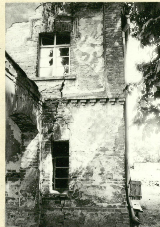
Fot.6. Fragment elewacji zachodniej rysy pęknięć w ścianach między otworami wschodniej osi.
