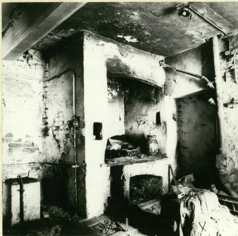
Fot.2. Wnętrze kuźni - widok na piec z otwartym paleniskim.
