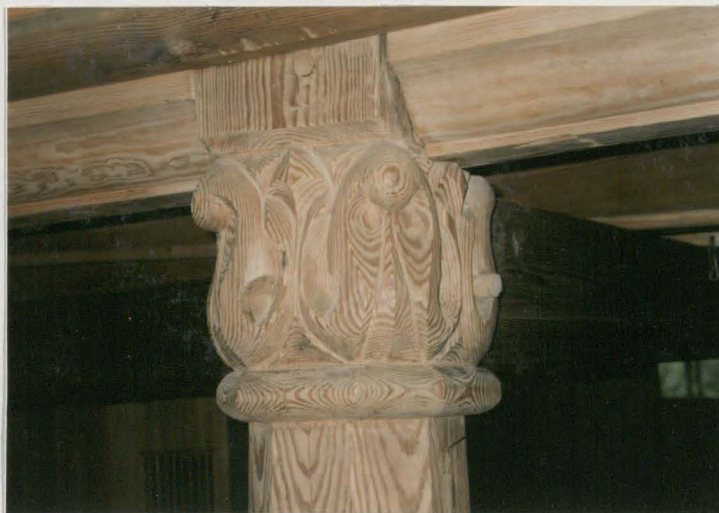
Głowica słupa podtrzymującego chór
