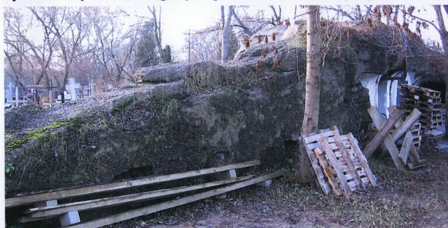
Ryc.76 Tradytor. Widoczne otwory wykute dla ładunków wybuchowych.
