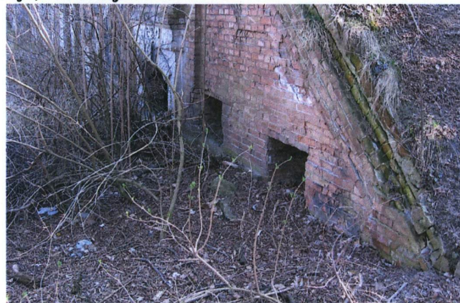
Ryc.48 Koszary szyjowe. Zachodni mur oporowy. Wnęki wykute do umieszczenia ładunków wybuchowych. Niszczący gzyms muru.
