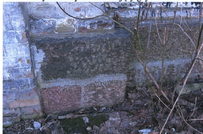
Ryc.49 Koszary szyjowe. Zachowany cokół z ciosów granitowych.
