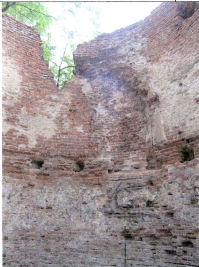
Ślady po mocowaniach klatki schodowej
