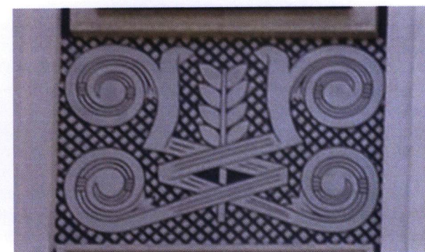
II. 70 Sgraffitowa dekoracja płycin podokiennych północnego łącznika
