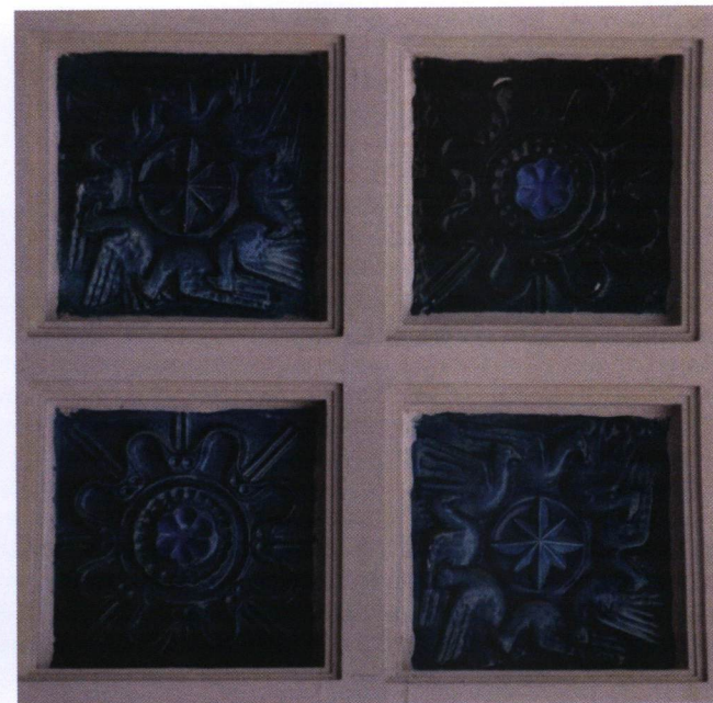
II. 77 Ceramiczne kasetony szklione na kolor turkusowy, różnicowanie barwne wynika z charakteru szkliva; 2 typy płytek
