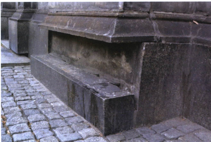
II. 54 Cokół elewacji frontowej z granitu – ubytek jednej z płyt okładziny
