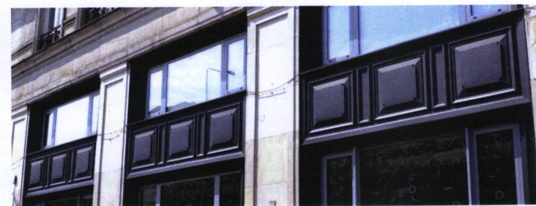
II. 113 Odtworzone płyciny między witrynami parteru i antresoli w d. barze mięsny - bibliotece
