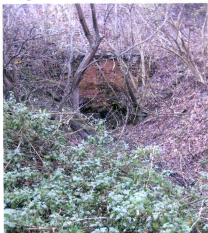
Ryc.8 Ceglany przepust wodny, tzw. spust bezciśnieniowy. Urządzenie hydrotechniczne z czasów budowy fortu, zlokalizowane w fosie prawego barku.
