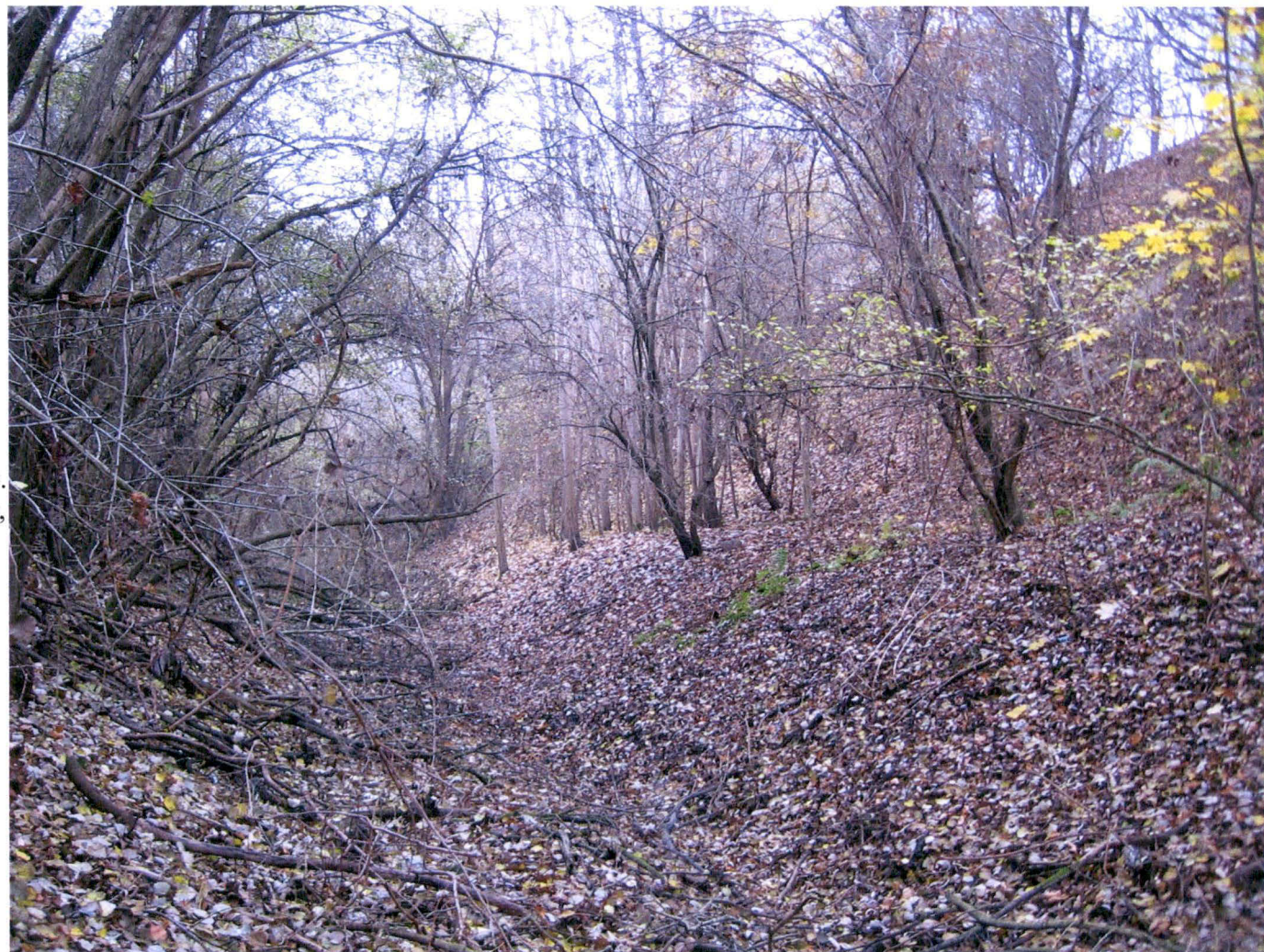
Ryc.10 Fosa w prawym barku fortu, widok od północy, czytelne dziś ukształtowanie dna fosy umożliwiające sezonowy przepływ wód opadowych, po prawej stronie przeciwskarpa fosy.
