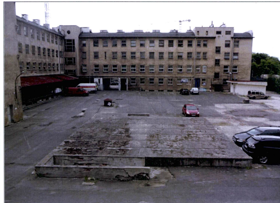
IL. 18. Skrzydło północne budynku od strony podwórza – na pierwszym planie zrealizowane w 1938 r. piwnice projektowanego skrzydła środkowego gmachu
