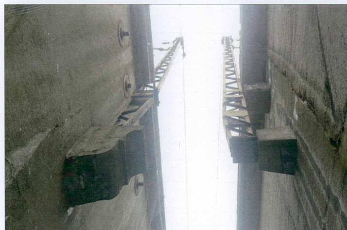
Słupy trakcyjne przymocowane do ścian bocznych wiaduktów w przyczółku północno-wschodnim.
