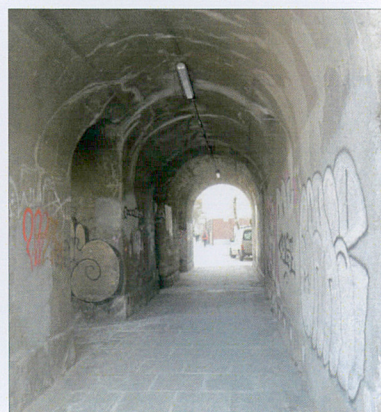
Przejście dla pieszych w przyczółku wiaduktu po stronie północno-zachodniej. Widoczna wtórna instalacja oświetleniowa.
