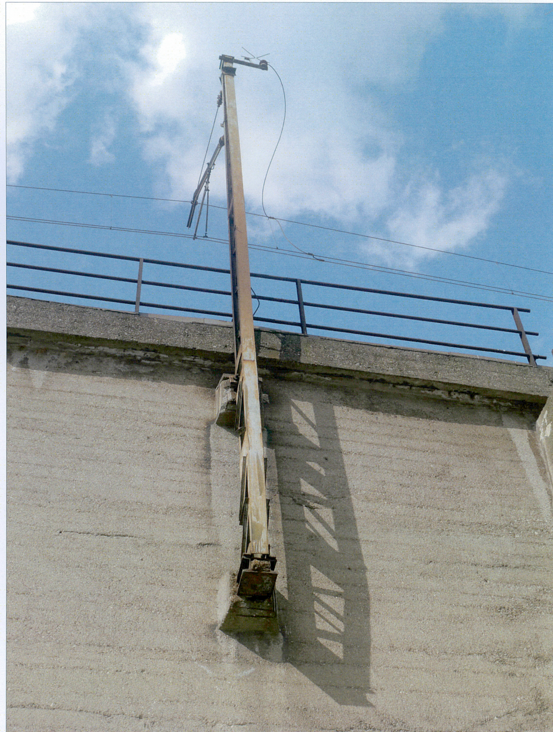
Słup trakcyjny przymocowany do południowo-wschodniej ściany wiaduktu.
