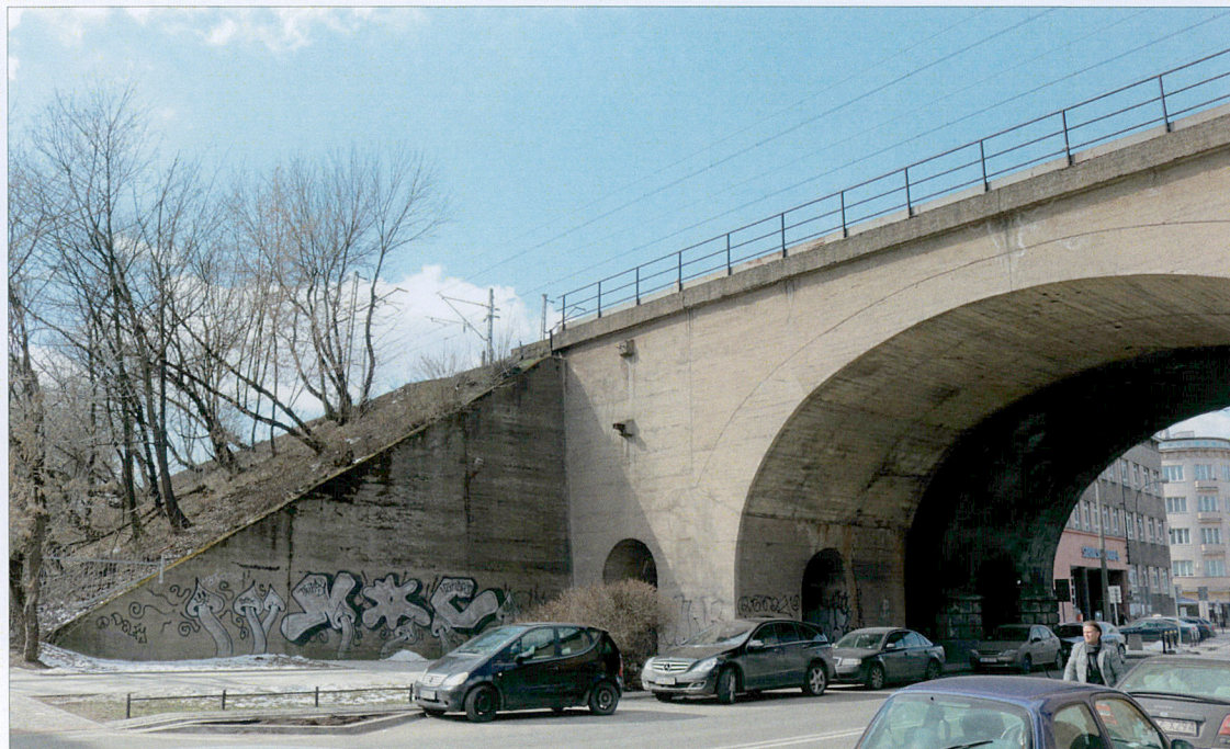
Południowe skrzydło i przyczółek wiaduktu z murem oporowym dla nasypu.
