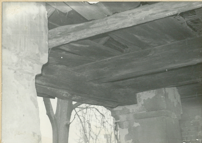
10. Osadzenie płatwi na kolumnach.
